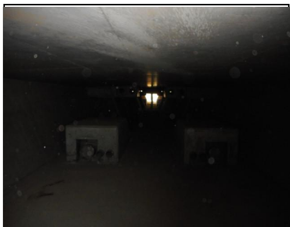
거터 내부 전경
