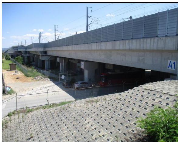
교량 측면 전경
